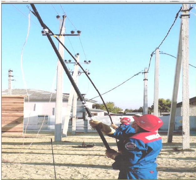
Рис. 2. Обучение работам под напряжением методом «на расстоянии»
