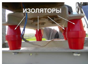
Рис. 3. Монтаж проходных изоляторов напряжением 6(10кВ)
