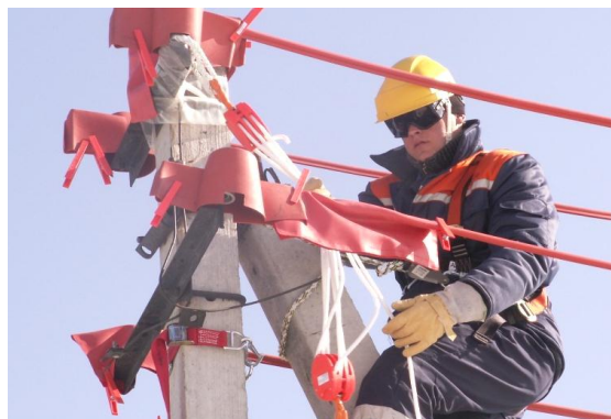
Рис. 1. Обучение работам под напряжением методом «в контакте»
