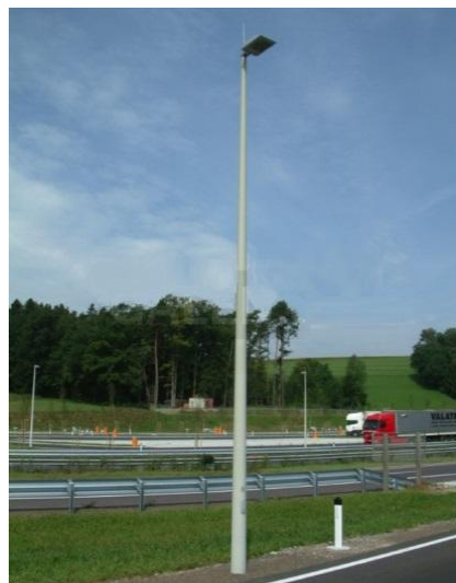
Рис. 4. Композитная опора освещения
