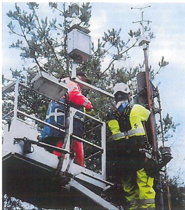
Монтажники компании Vattenfall устанавливают метеостанцию вблизи датчика Power Donut2.
