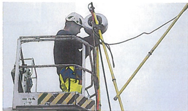
Маркус Ауствик устанавливает датчик Power Donut2 на проводе воздушной линии.
