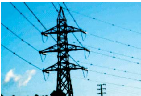
Рис. 6. Устройства повышения визуальной доступности проводов ВЛ
