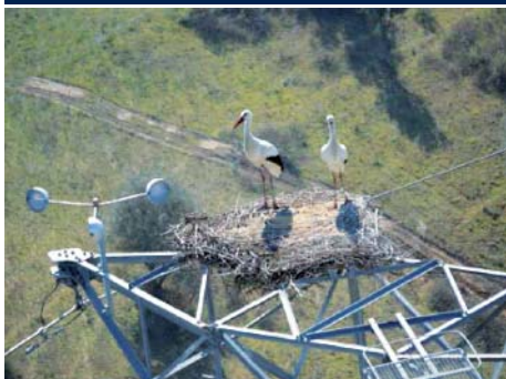
Рис. 9. Вращаемое ветром устройство — помеха гнездованию, и рядом платформа для формирования гнезда
