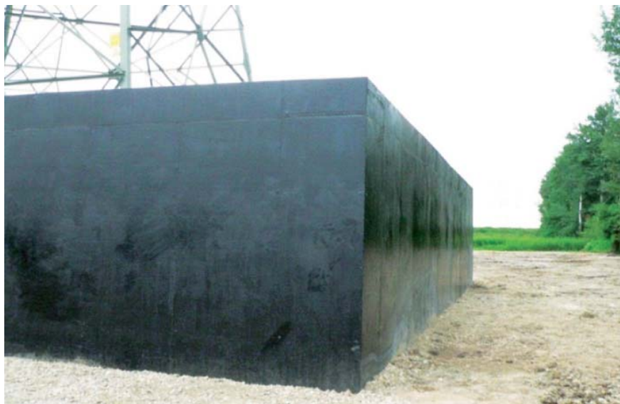
Рис. 14. Усиленное основание фундамента опоры в зоне изменения русла Дуная
